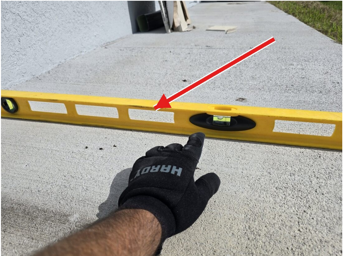
Verificación de pendiente con nivel / Slope verification with level
