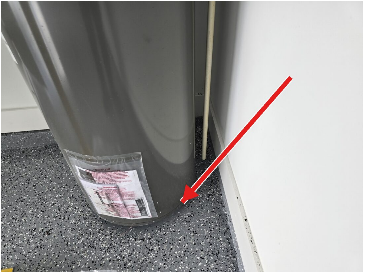
Base del calentador sin bandeja / Water heater base with no pan
