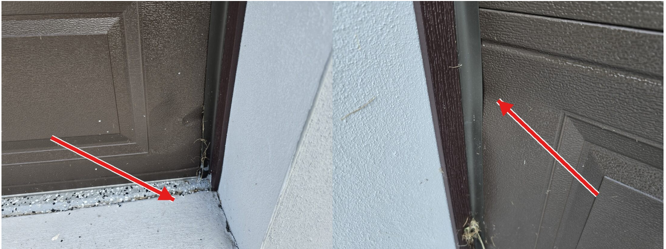
Sello con desechos atrapados / Seal with trapped debris
