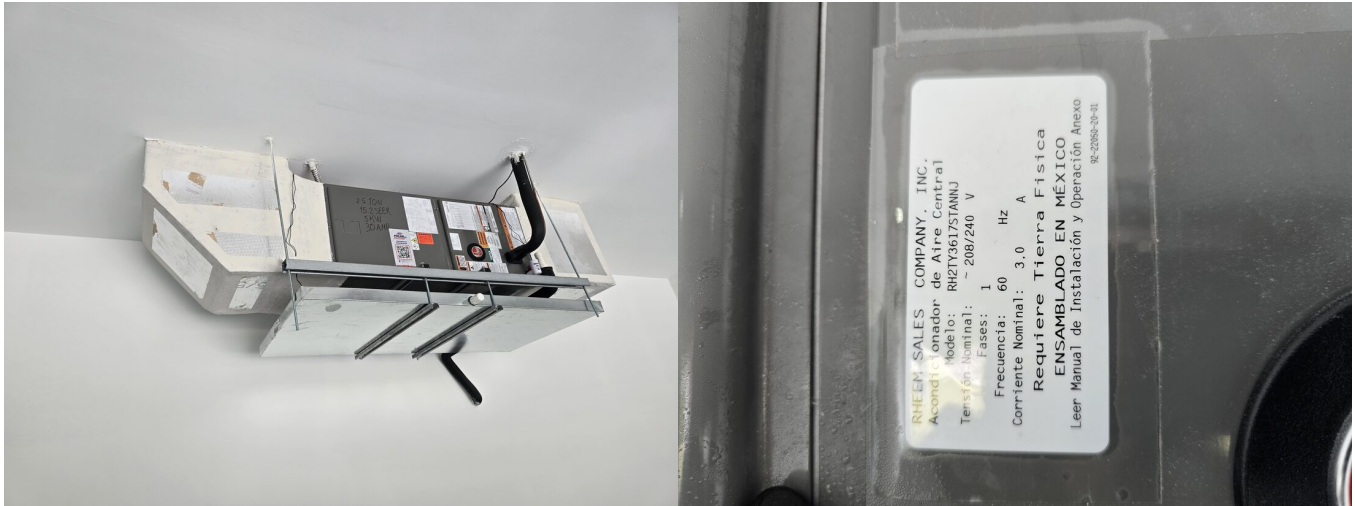
Manejador de aire suspendido / Suspended air handler
